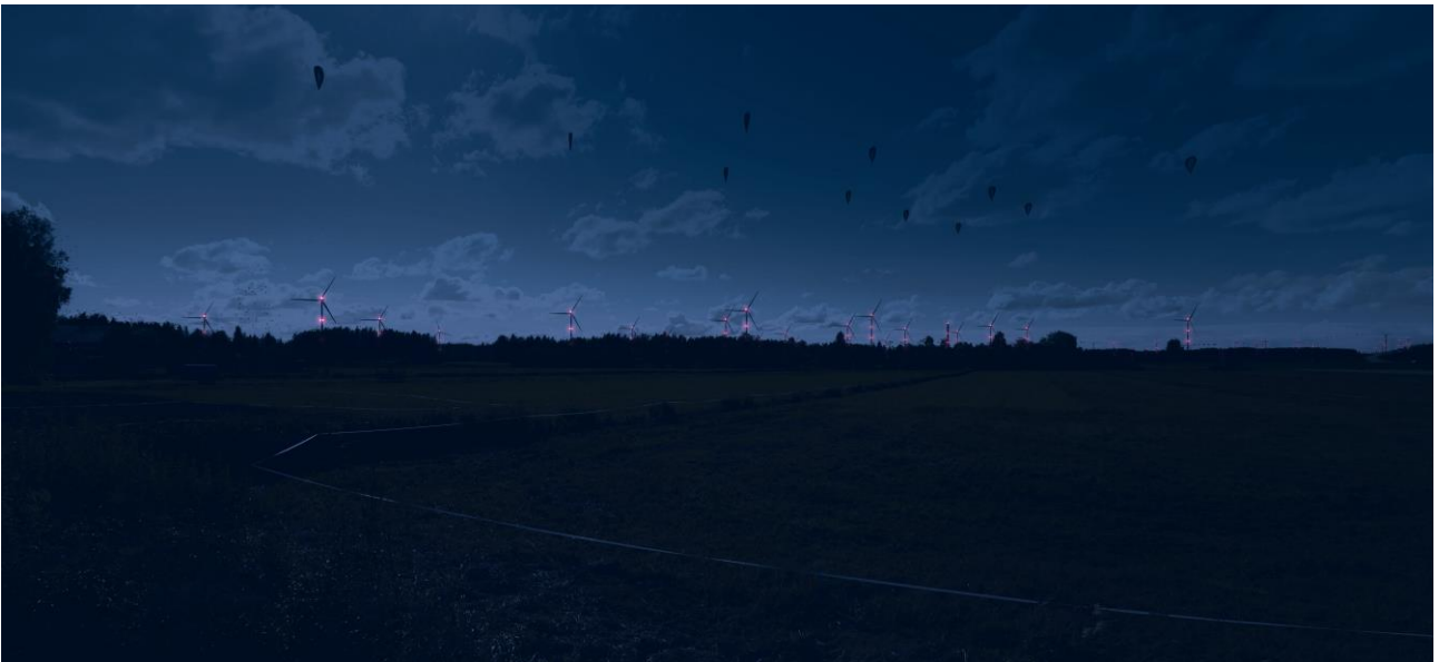
Kuva 107. Kuvakulma 8E Lylyn peltoaukealta Kukonkylästä, uusi kesän 2024 valokuva tuulimittausmaston kanssa. Kuvasovite, käsitelty yökuvaksi korostetuilla valoilla.
