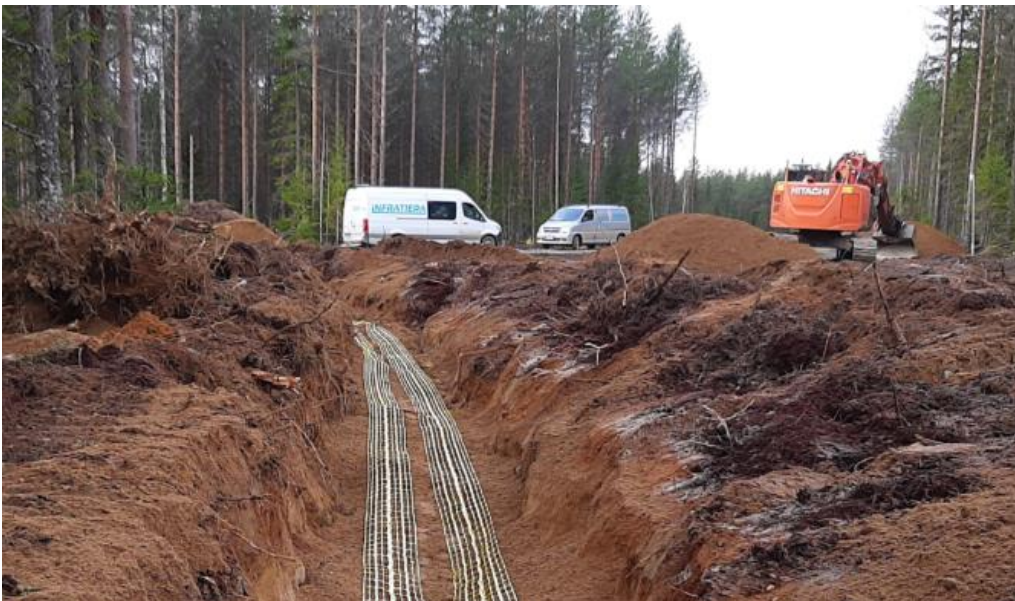
Kuva 13. Tyypillinen tuulipuiston kaapelioja (Kuva: Infratiera)
